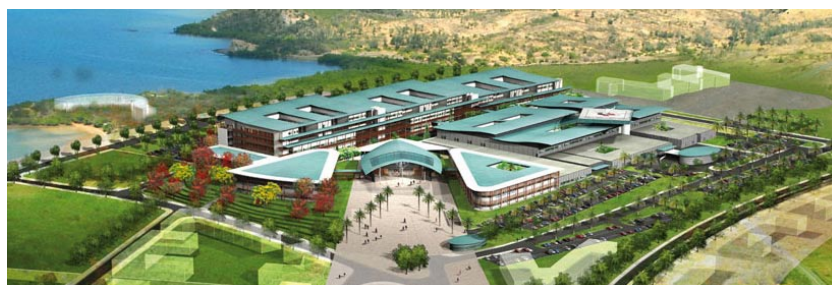
Le campus du médipôle en périphérie Nord de Nouméa (III.A.Zuga S.A.R.L. – Agence Beauvais et associés)
